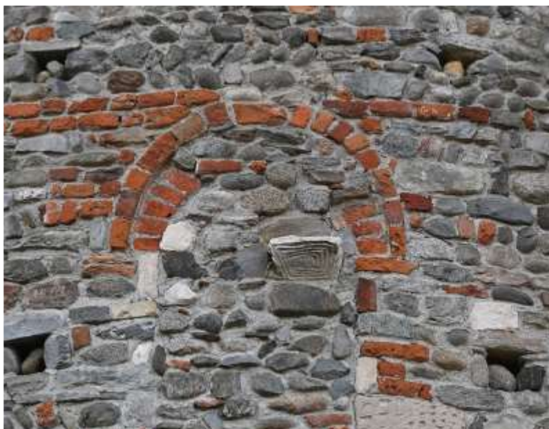
Sesto Calende (VA), muratura esterna dell'abside dell'abbazia di San Donato con elementi lavorati di reimpiego
