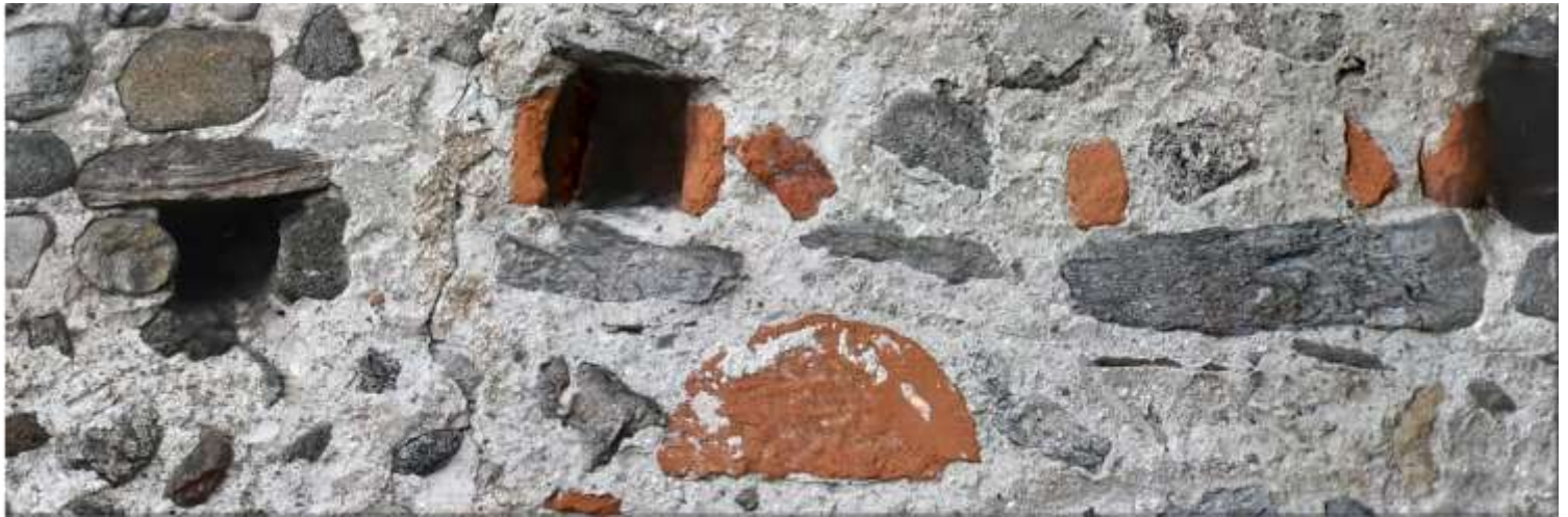
Particolare del riutilizzo di elementi fittili nella muratura dell'Oratorio di San Vincenzo a Sesto Calende (VA)
